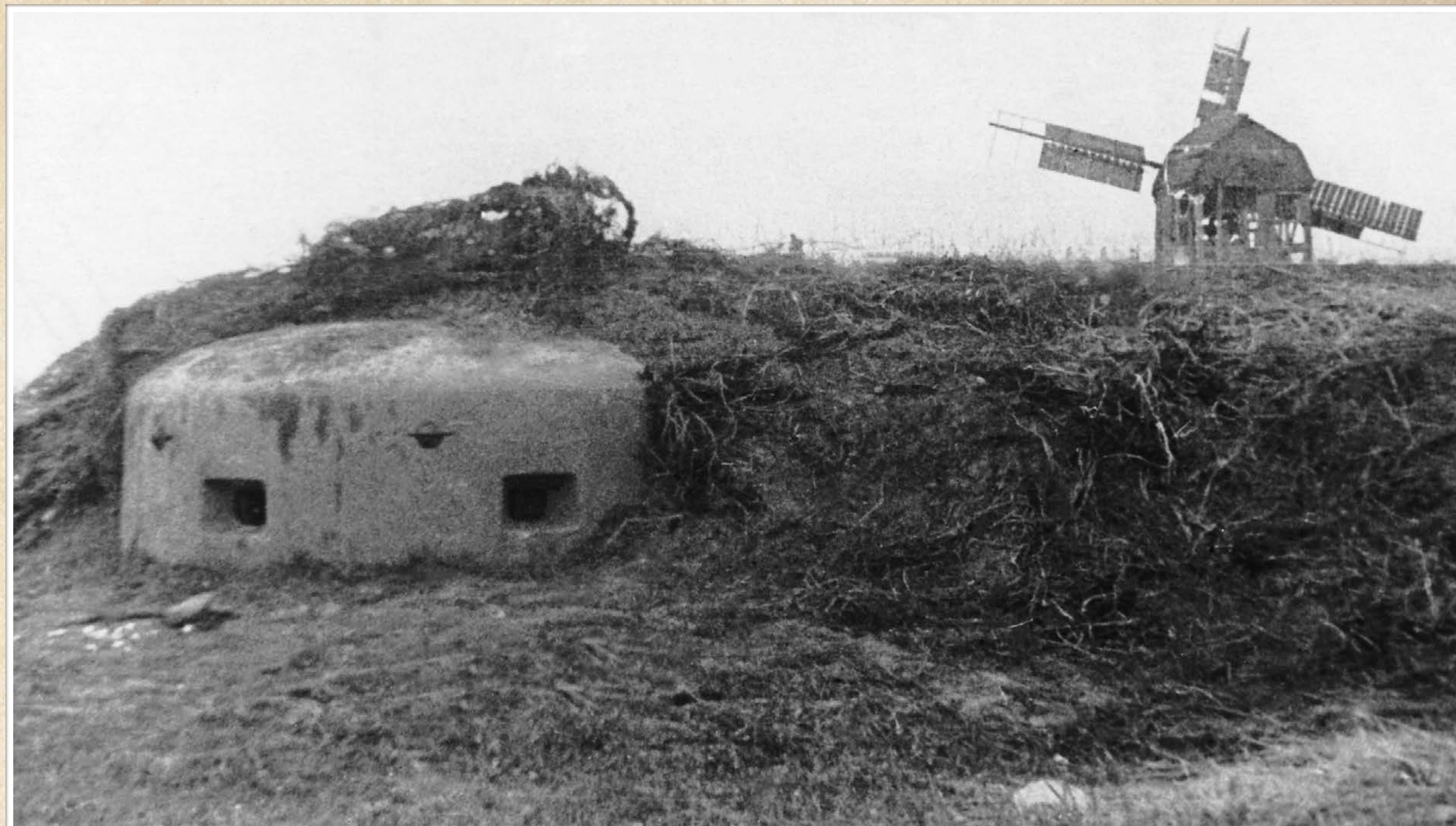
Żelbetonowe, stałe stanowisko ogniowe, tzw. DOT. Prusy Wschodnie, 1944 r.
